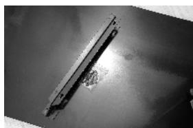
Relevez l'appareil, assemblez avec precaution les trous dans les supports et les vis sur la la surface, baissez l'appareil pour fixer les supports. Il vaut mieux faire cette opération a deux.
